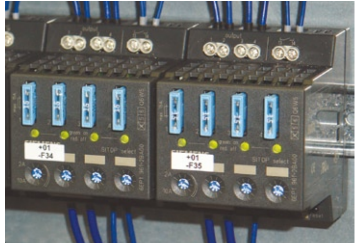
Je nach Leitungsquerschnitt könnten Kurzschlüsse die Netzteile in die Knie zwingen. Die Diagnosemodule Sitop Select verhindern dies.
