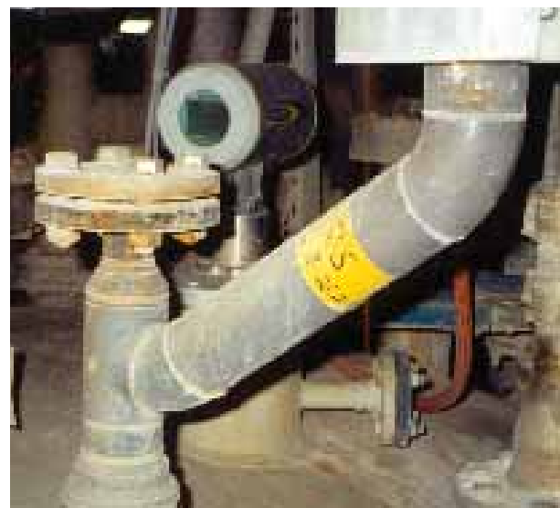
Selbst unter den schwierigen Bedingungen dieses Dioxid-Reaktionsgefäßes ermöglicht das Siemens Radar eine zuverlässige Füllstandsmessung: Ein Reinigungskit spült die Antenne in regelmäßigen Abständen, ohne dabei den Prozess zu unterbrechen.
