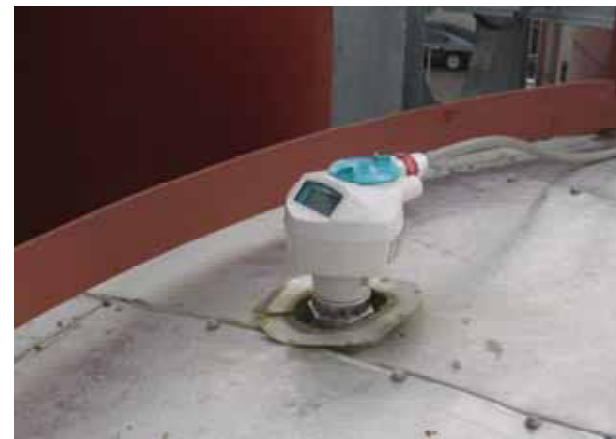
Der kompakte SITRANS LR250 ist zum Einbau in kleine Behälteröffnungen und nahe der Behälterwand geeignet.
