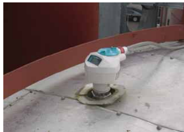
Très compact, le SITRANS LR250 s'installe facilement dans de petites ouvertures, et à proximité des parois des réservoirs.
