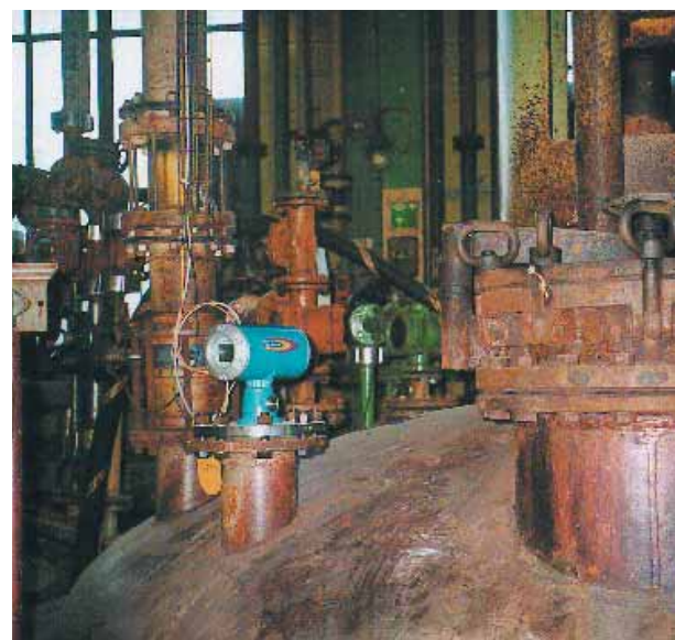
DyStar Textilfarben GmbH & Co. de Leverkusen, Alemania, utiliza SITRANS LR 300 para medir con fiabilidad los pigmentos.
