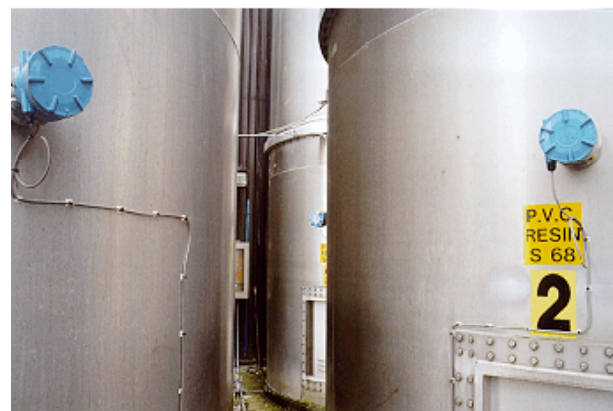
Mercap de Milltronics mide el nivel de polvo de PVC con objeto de asegurar una máxima eficiencia productiva en Anglian Windows.
