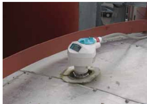
El compacto transmisor de nivel SITRANS LR250 se puede instalar en una pequeña boquilla del tanque y cerca de las paredes del mismo.
