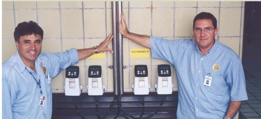
Braumeister Vicente Fioroto und Wartungs-Verantwortlicher Joao Luiz mit Messumformern für vier der SITRANS F M Messaufnehmer zur Dosierung der Zusatzstoffe beim Filtrationsprozess.
