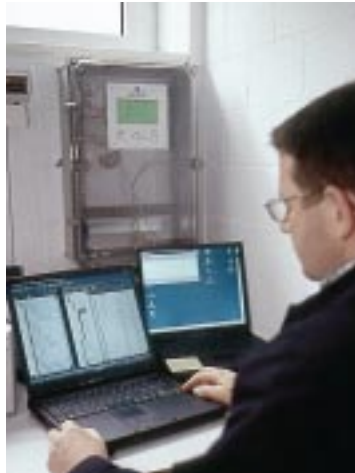
Über einen Laptop hat Genter Inhaustec für die Wartung einen Internet-Fernzugriff auf das EIB-System realisiert.
