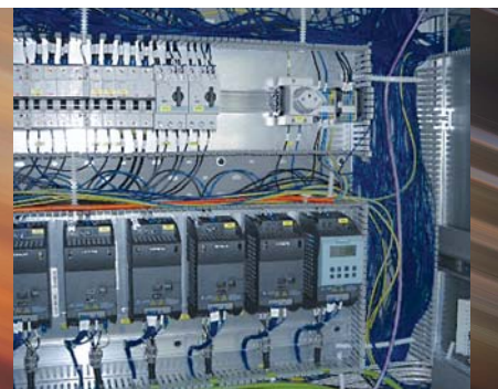
Baugleiche Frequenzumrichter in Sekundenschnelle „klonen“: Dazu wird auf den G110 einfach ein Bedienfeld aufgesteckt
