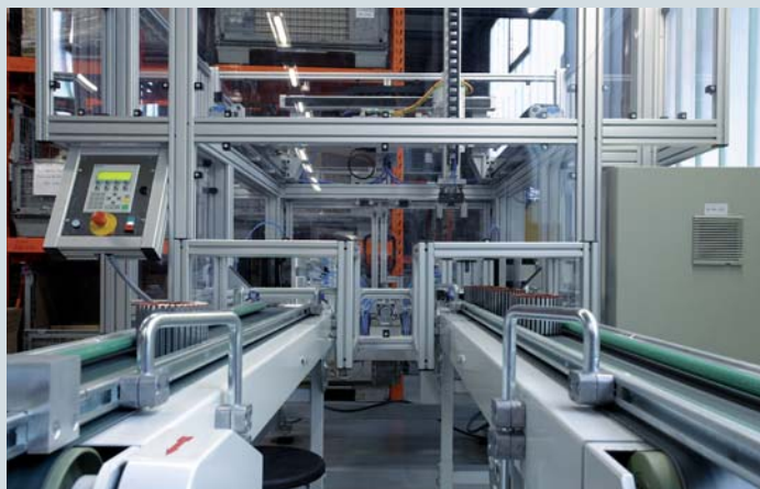
Das rechte Förderband ist der Materialpuffer der Papierisoliermaschine, links werden die isolierten Statoren abtransportiert
