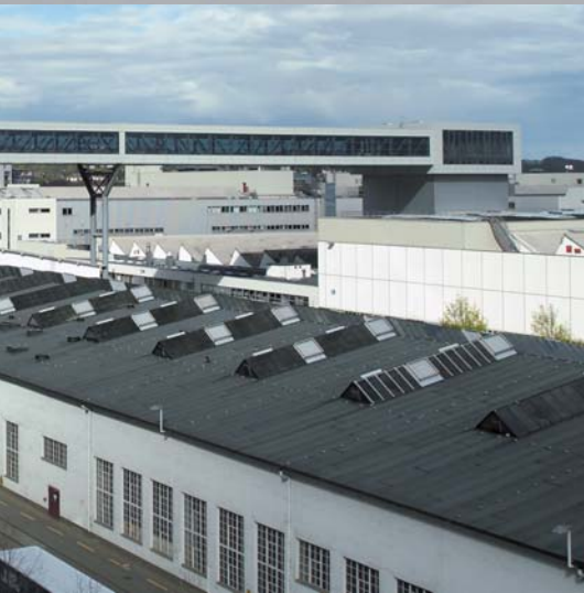
Die 140 Meter lange Förderbrücke transportiert in 35 Meter Höhe die Karossen in die Lackierung
