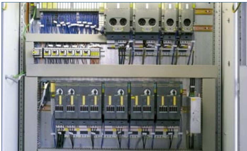
Bild 3: An das feinskalierbare dezentrale Peripheriesystem Simatic ET200S können alle gängigen Sensoren und Aktoren direkt vor Ort angeschlossen werden. Vom einfachen Digitaleingang bis zum Frequenzumrichter steht dazu ein umfangreiches Spektrum an Peripheriemodulen zur Verfügung. Selbst sicherheitsrelevante Daten für den Personen- und Maschinenschutz können bearbeitet werden. Die Zentralsteuerung tauscht über den Ethernet-Feldbus Profinet IO Daten mit der Peripherie in Echtzeit aus. Fotos: Siemens
