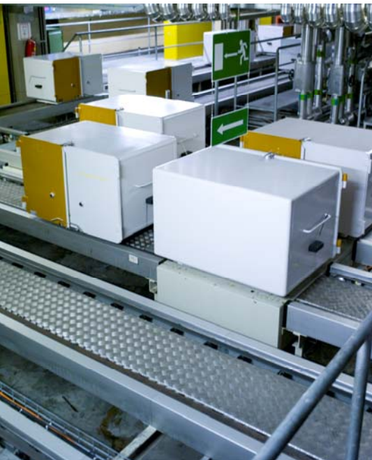
Die automatische Containertransportanlage des AKH Wien ist die größte ihrer Art in Österreich
