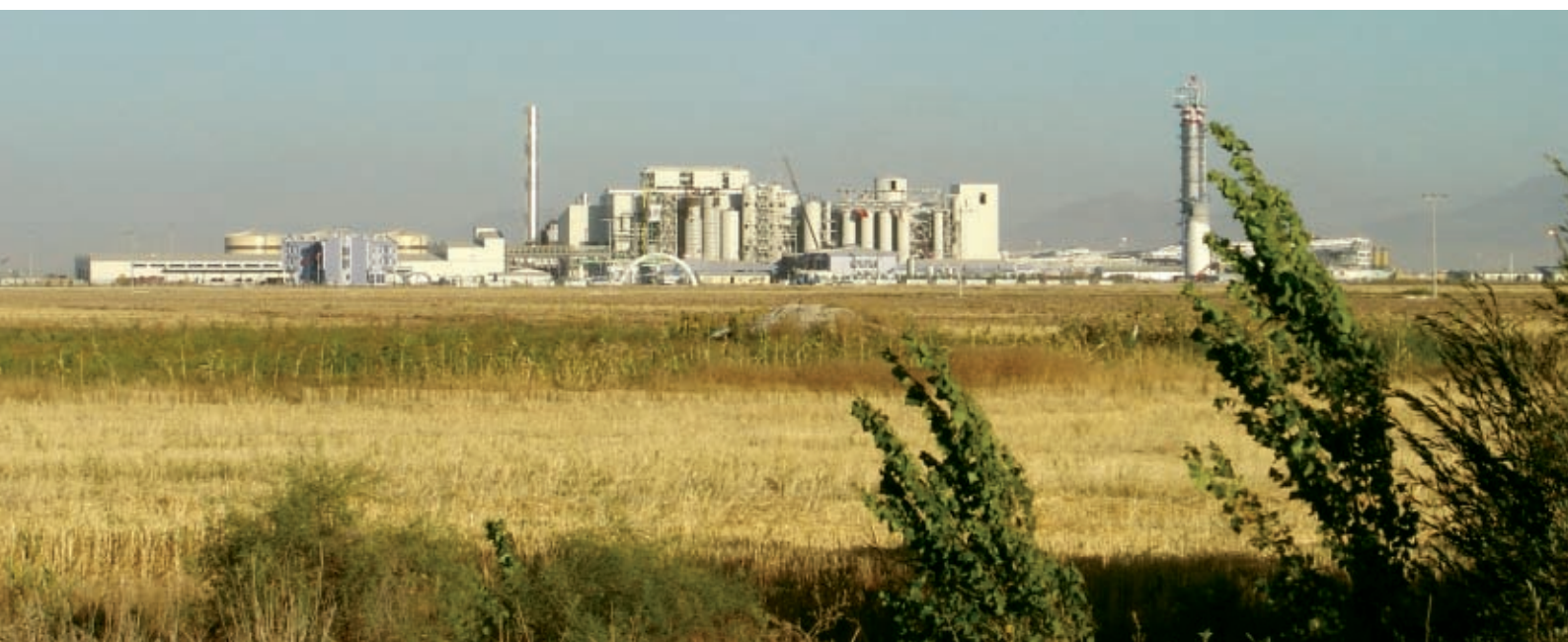
Abb. 1: Die neue Zuckerfabrik in Cumra ist im wahrsten Sinne des Wortes eine „Greenfield-Anlage“ – gebaut in Cumra, 50 km südöstlich von Konya im Hochland von Anatolien, Türkei.
