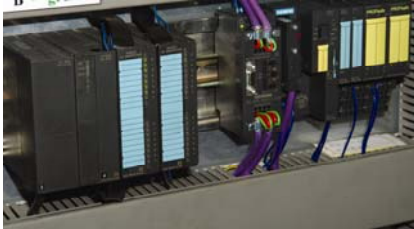
Abb. 4: Um unterschiedliche Sicherheitskonzepte umzusetzen, wird eine ET 2005 High Feature mit fehlersicheren Modulen über PROFIsafe an die Steuerung des Subsystems angehängt
