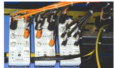
Abb. 4: Durch die Feldmodule mit AS-i-Anschluss ergibt sich eine einfache, übersichtliche Sicherheitstechnik, die zudem sehr robust ist
