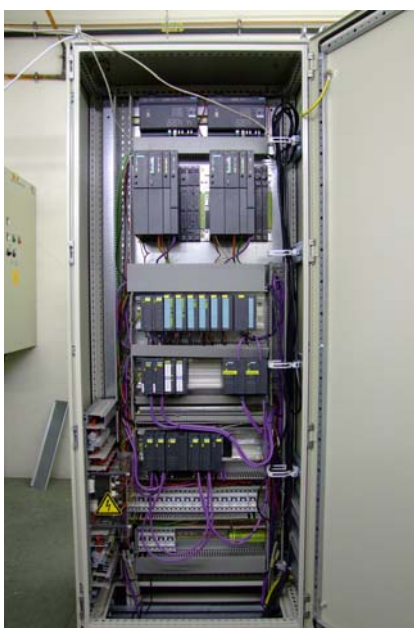
Abb. 1: Hochverfügbare Automatisierungsgeräte SIMATIC S7-400FH integrieren die Standard- und sicherheitsgerichtete SPS-Funktionalität sicher und wirtschaftlich
