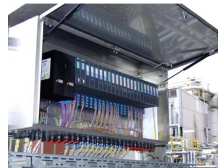
Abb. 3: Eigensichere Peripheriebaugruppen SIMATIC ET200iSP können in Ex-Zone 1 ohne zusätzliche Schutzmaßnahmen betrieben werden
