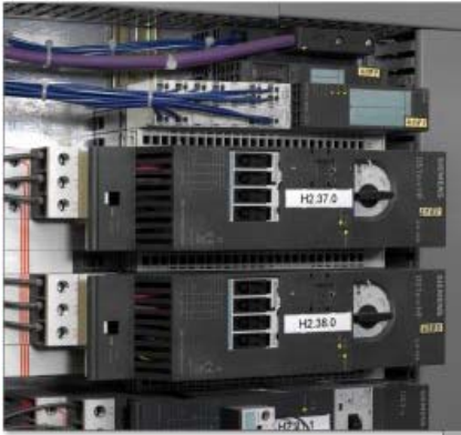
Die Motorstarter der Baureihe Simatic ET 200S sind deutlich einfacher und schneller zu installieren als konventionelle Lösungen
