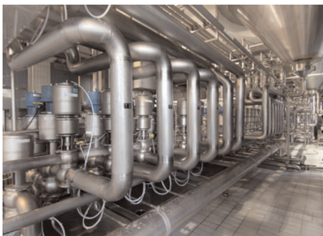
Bild 3: Eine einzige speicherprogrammierbare Steuerung Simatic S7-400 steuert bei der Spaten-Franziskaner-Bräu in München bereichsübergreifend ca. 3.000 Ventile, betreibt 182 analoge Eingänge und kontrolliert 60 PID-Regelkreise.
