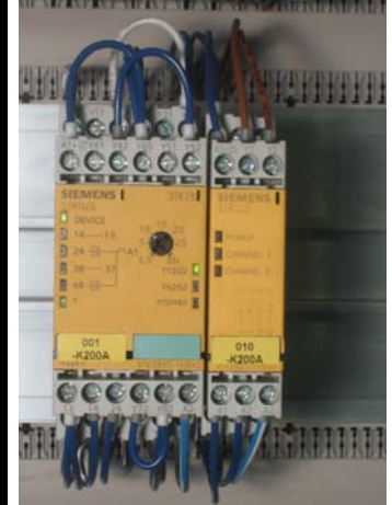
Abb. 2: Das elektronische Sicherheitsschaltgerät SIRIUS 3TK28 ist speziell für Anwendung mit zusätzlicher Schlüsselschalterfunktion entwickelt worden
